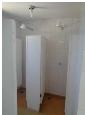
Padrão boxe com chuveiro elétrico –
