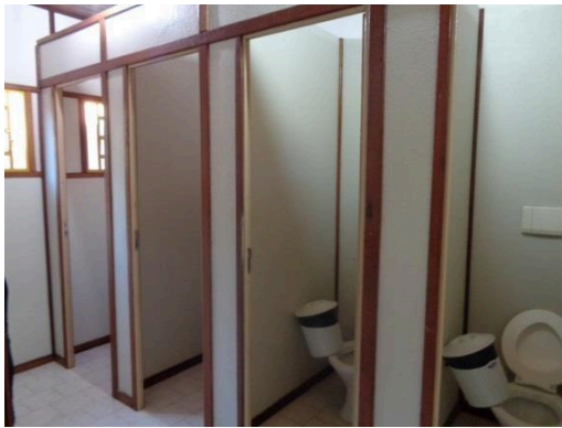
Padrão banheiro alojamento Amarelo
