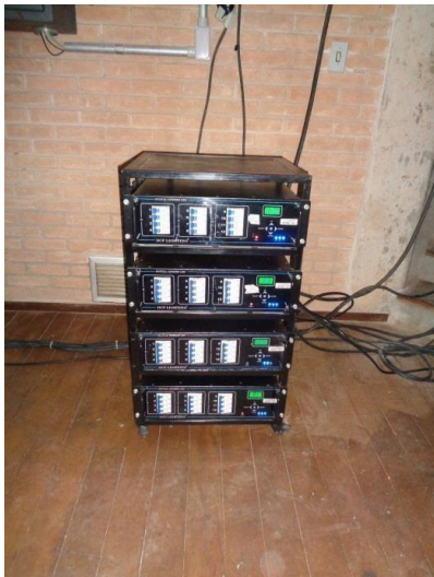
4 Dimmer Energy 12c / 4 kW Analógico / Digital
