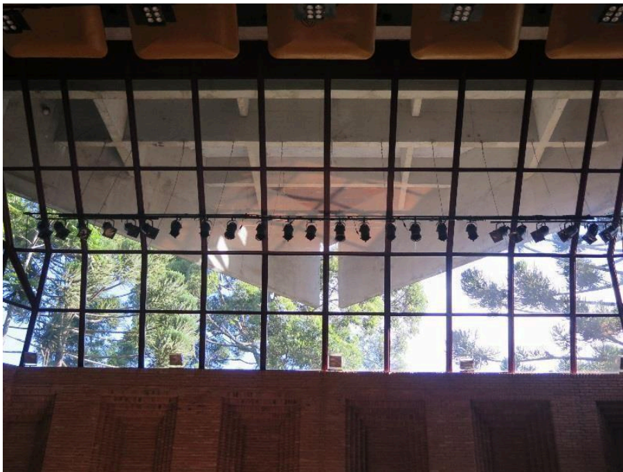
Iluminação - contra: 24 canhões lâmpada par 64 F/5 (1000w)
