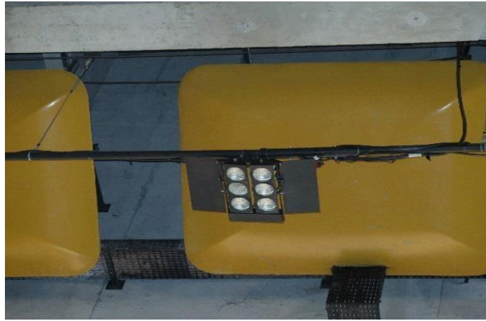
10 mini brut – 6 lampadas – par 36 – 650w
