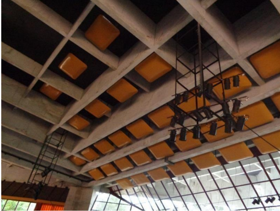
Varas de iluminação cênica fixa
