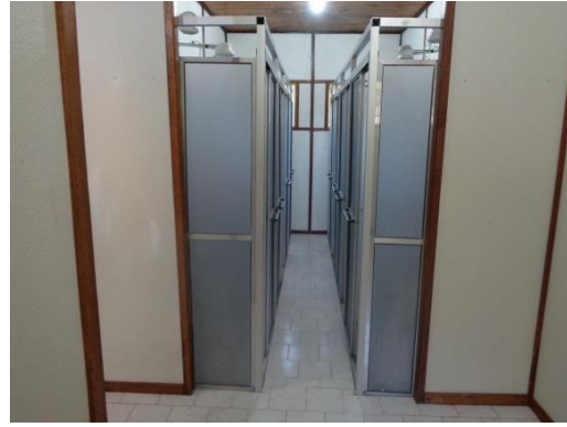
Corredor de boxes com chuveiros
