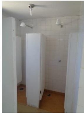
Padrão boxe com chuveiro elétrico - alojamento Verde
