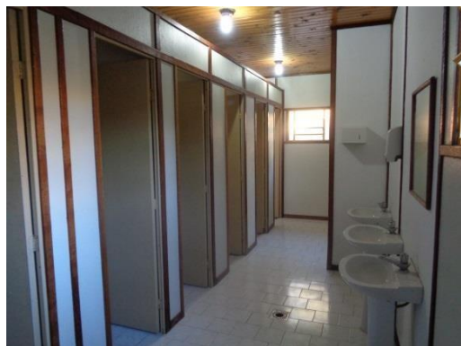
Padrão banheiro alojamento Amarelo
