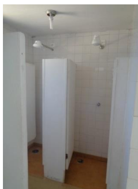
Padrão boxe com chuveiro elétrico - alojamento Verde
